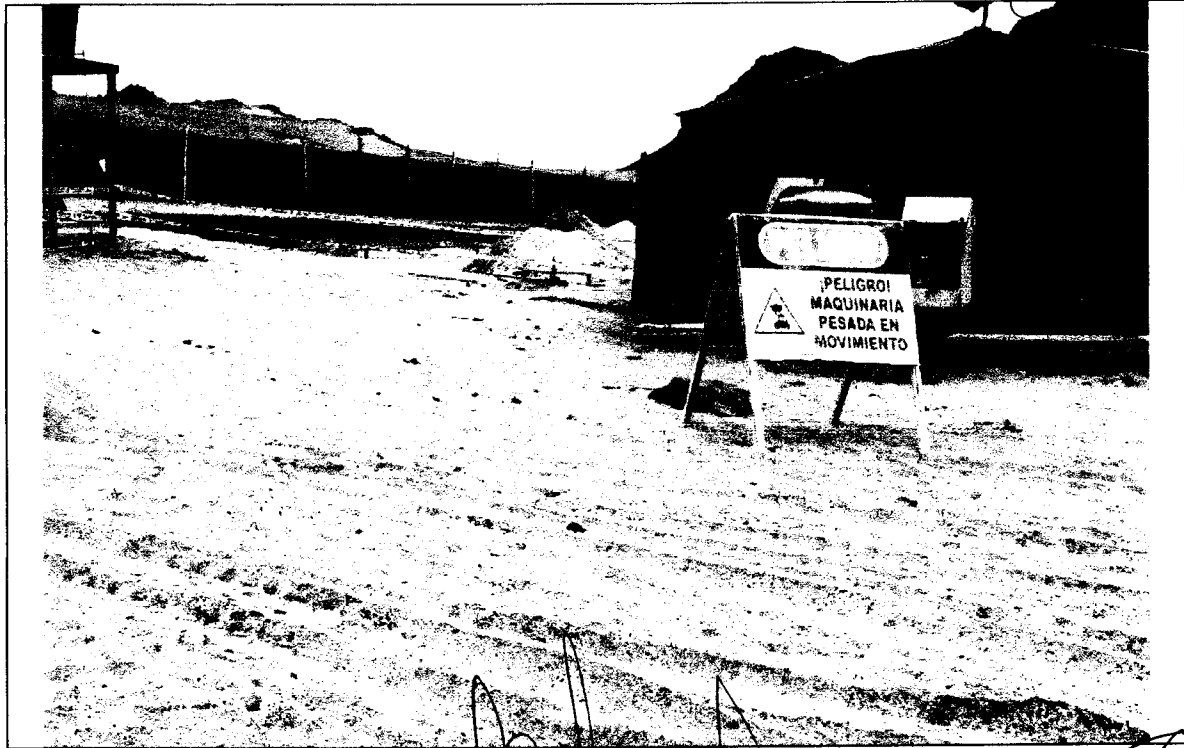
Foto N° 10: INSTALACION DE SEÑALIZACION ADVIRTIENDO LA PRESENCIA DE MAQUINARIA PESADA EN MOVIMIENTO.
