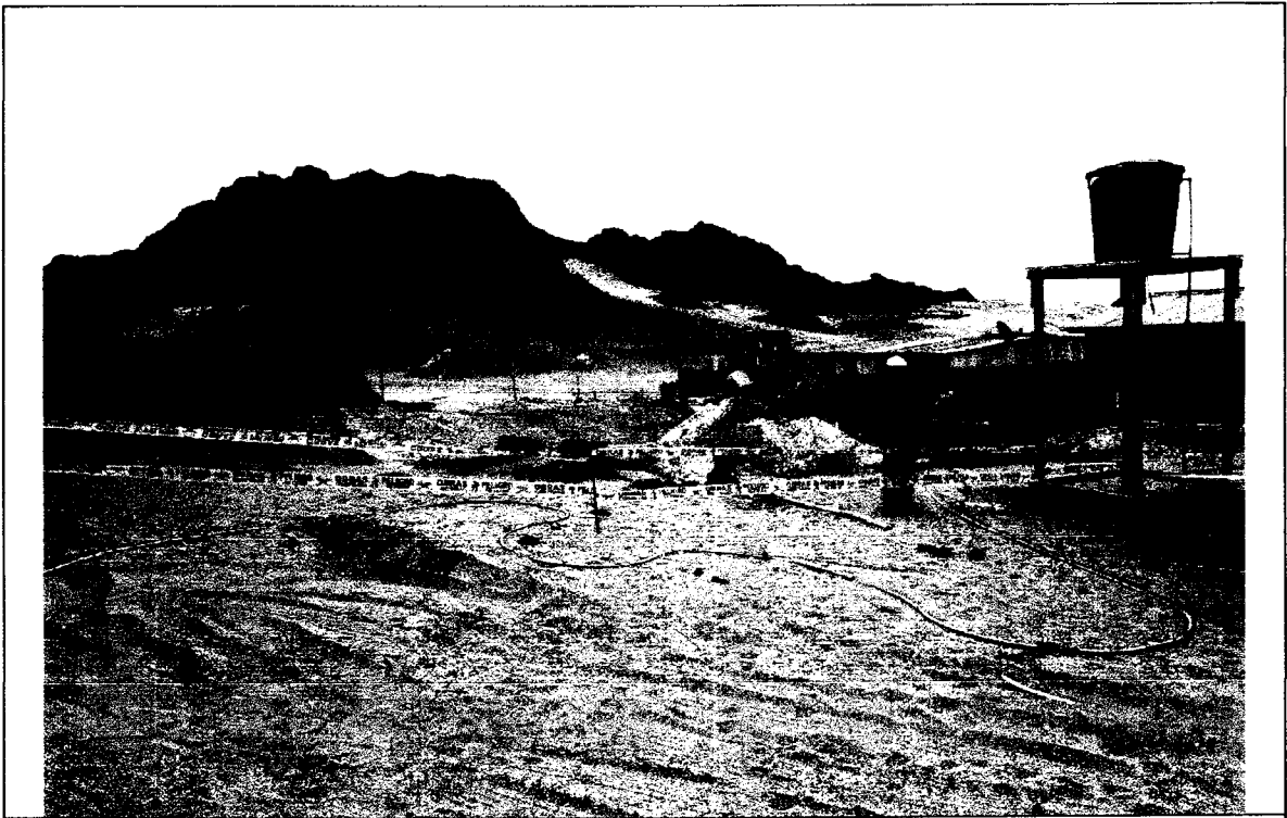
Foto N° 11: INSTALACION DE CINTA DE SEGURIDAD, MEDIDA PREVENTIVA PARA EVITAR ACCIDENTES.
