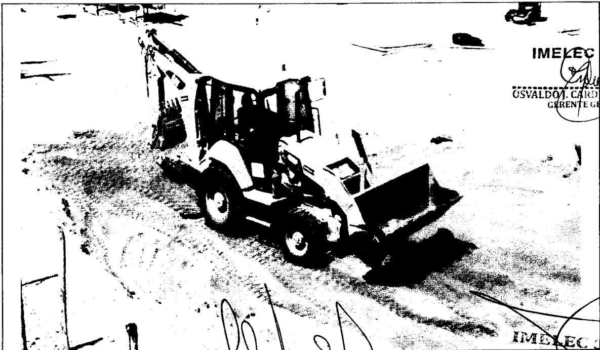
Foto N° 12: EXCAVACION MASIVA CON MAQUINARIA, PARA NIVELAR EL TERRENO.
