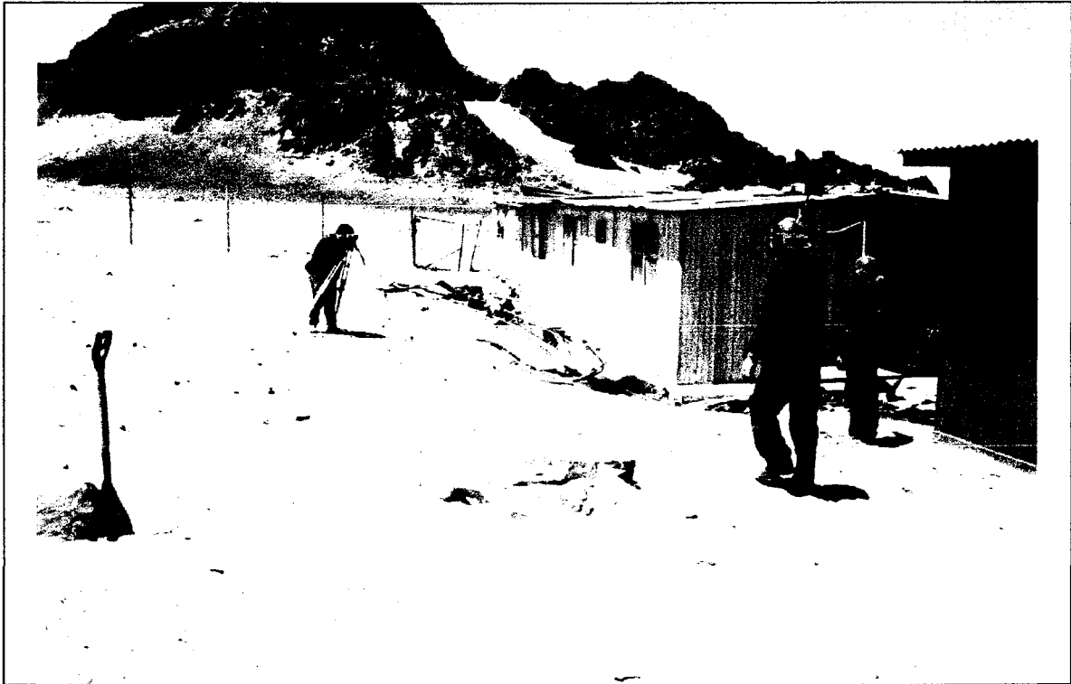
Foto N° 05: TRAZO Y NIVELACION INICIAL CON NIVEL TOPOGRAFICO.
