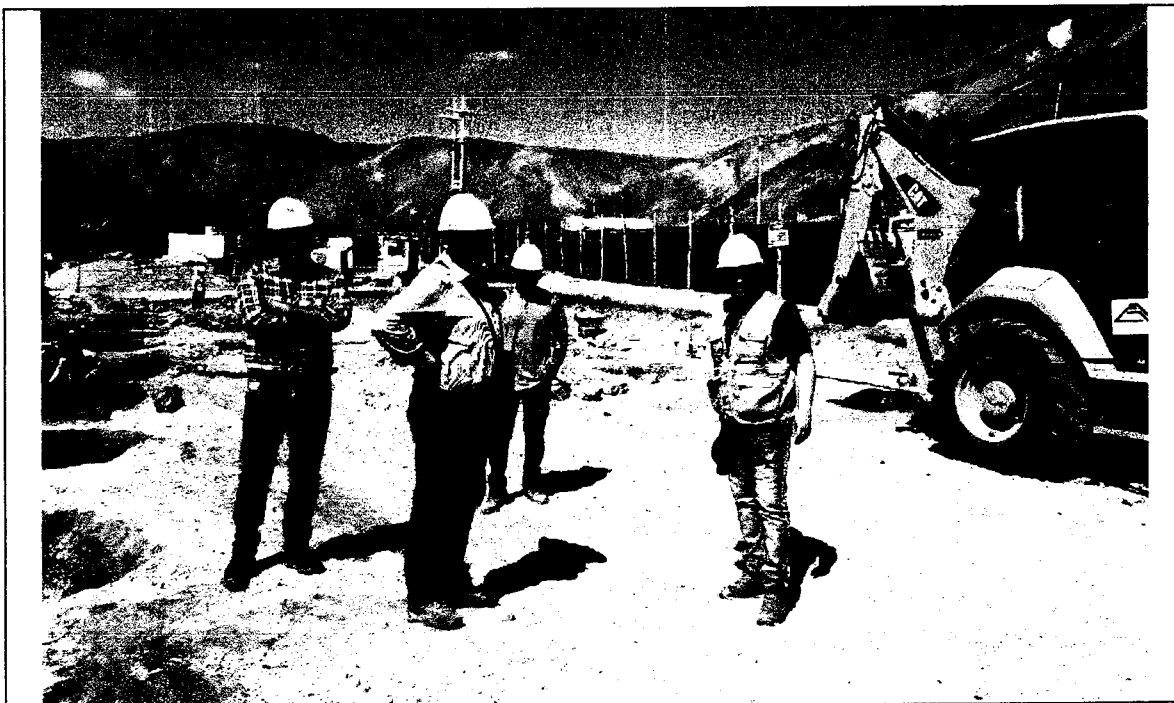
Foto N° 15: VERIFICACION DE LAS EXCAVACIONES EN PRESENCIA DEL RESIDENTE, SUPERVISION Y COORDINADOR DE LA ENTIDAD.
