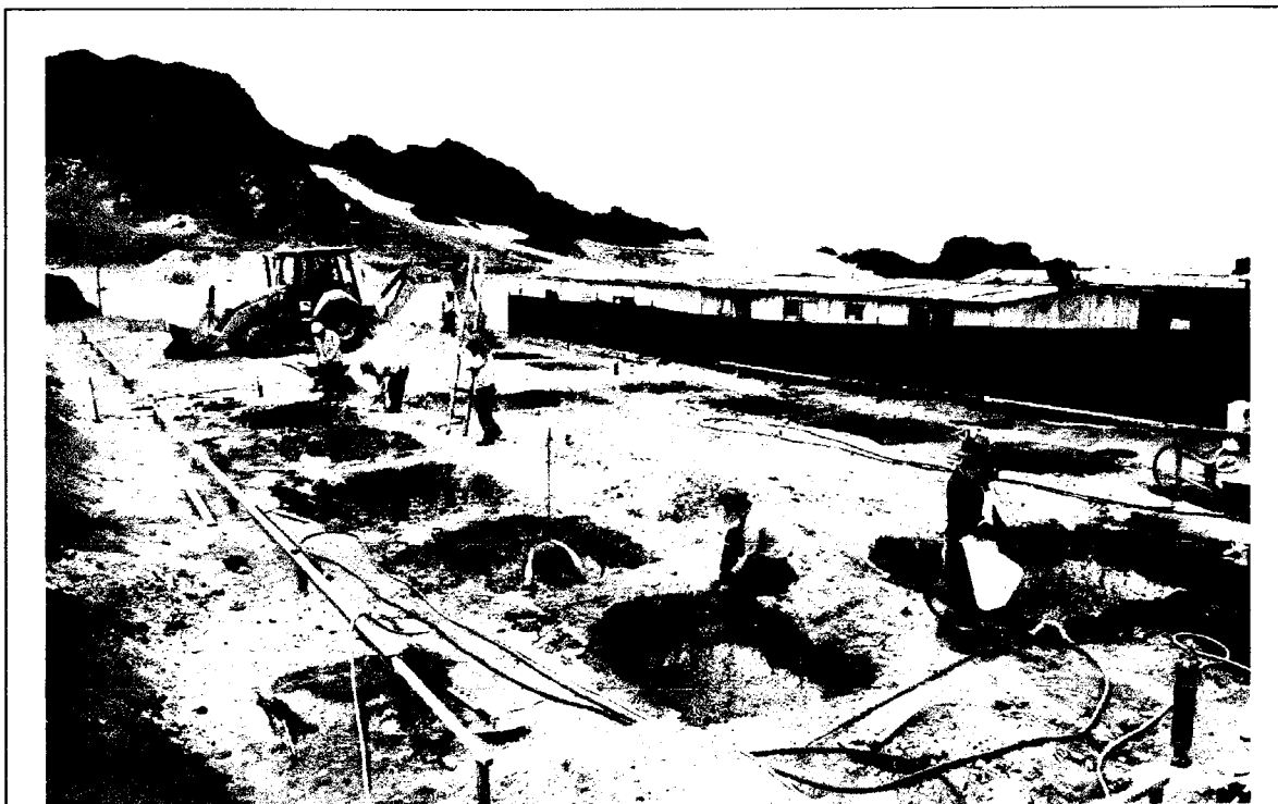
Foto N° 13: EXCAVACION DE LAS ZAPATAS Y SUB - ZAPATAS CON MAQUINARIA, EN EL MODULO I Y MODULO II.
