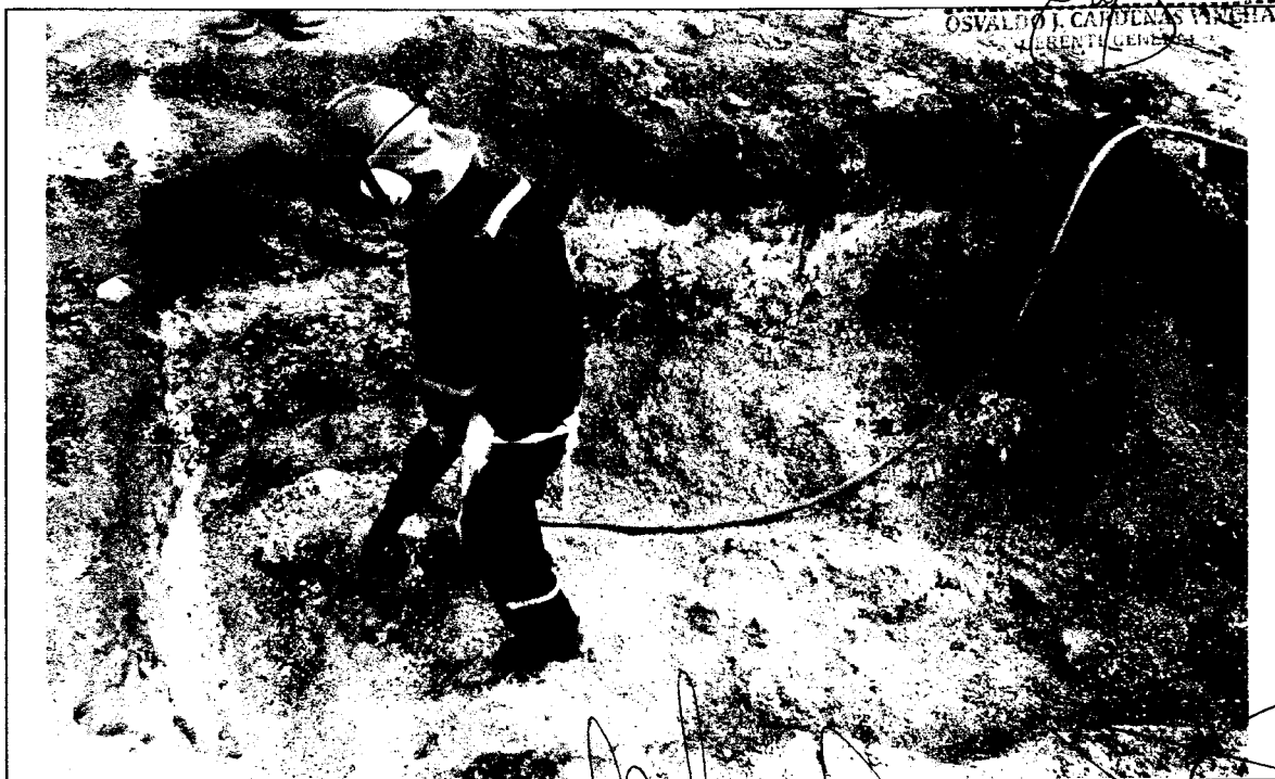
Foto N° 14: TRABAJOS DE DEMOLICION POR PROSENCIA DE ROCA EN LAS ZAPATAS Y SUB-ZAPATAS.
